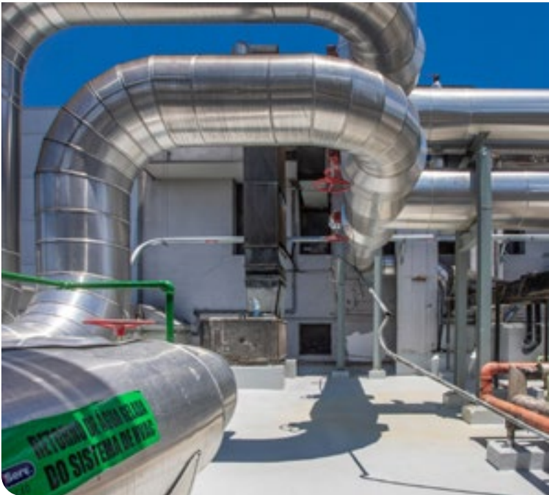
↑ A nova Central de Água Gelada do Morumbi provê o resfriamento de centros cirúrgicos e áreas de internação, com um controle térmico preciso, seguro e econômico
