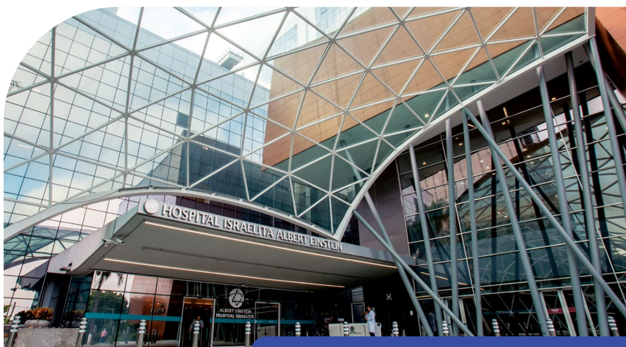
Entrada a la Sala de Emergencias de la unidad Morumbi
