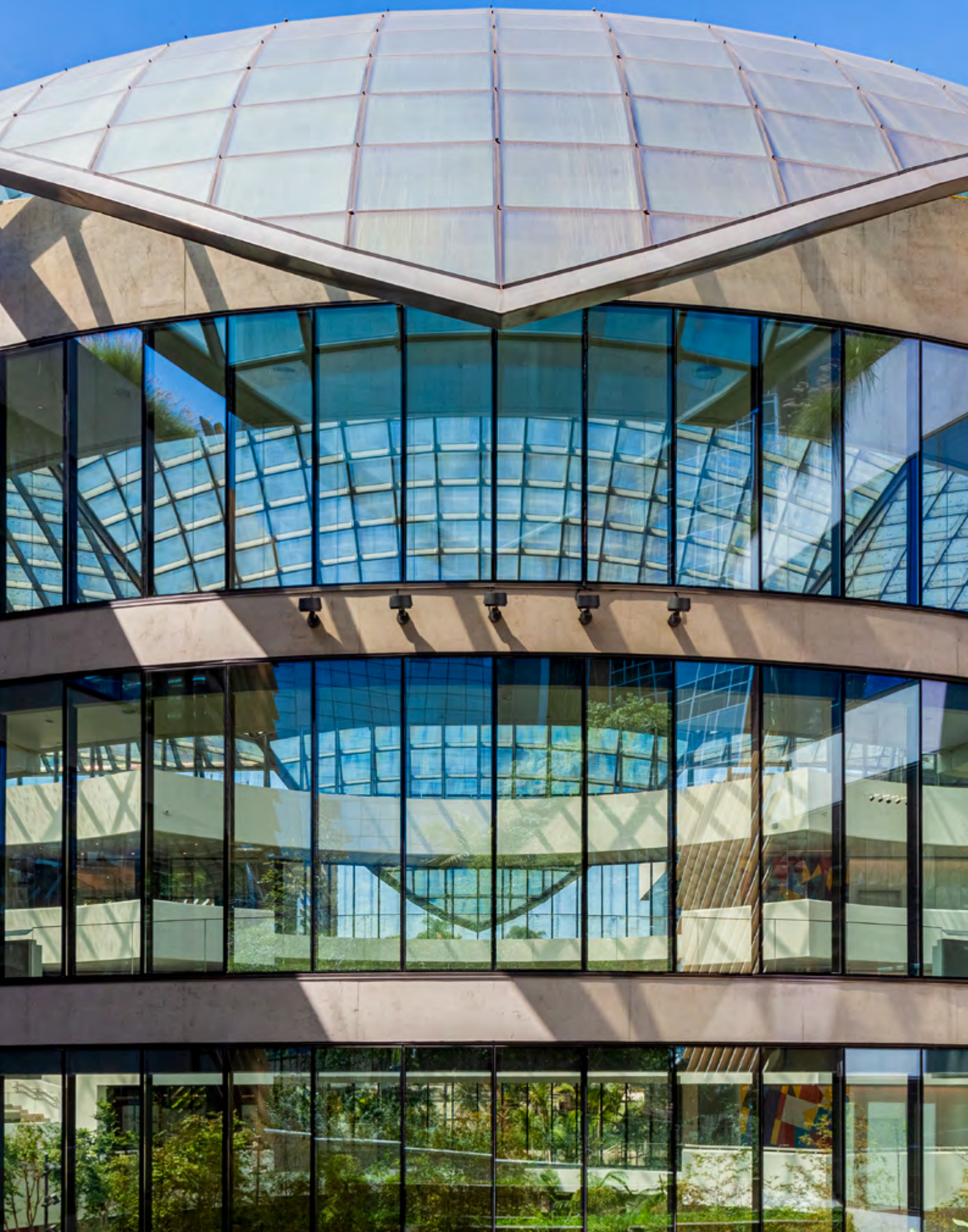
Vista lateral do prédio do Centro de Ensino e Pesquisa Cecília e Abram Szajman
