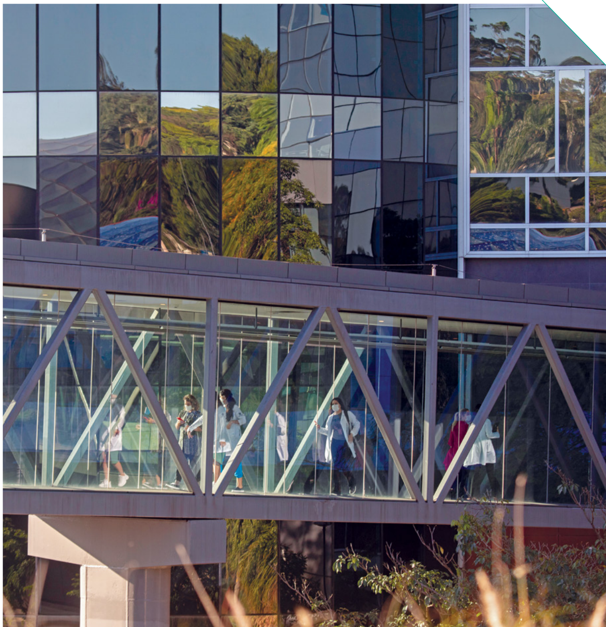
Puente peatonal que integra el Centro de Enseñanza e Investigación Albert Einstein a la unidad hospitalaria de Morumbi
