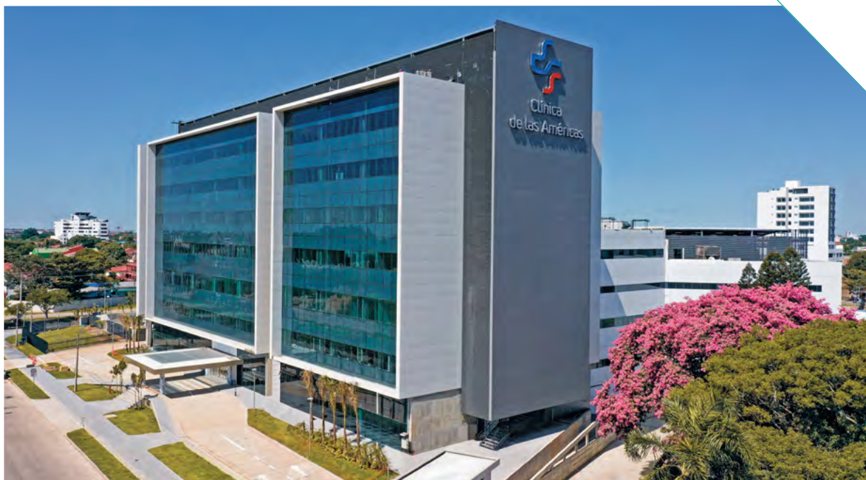
Fachada do Hospital Clínica de las Américas, em Santa Cruz de La Sierra, na Bolívia
